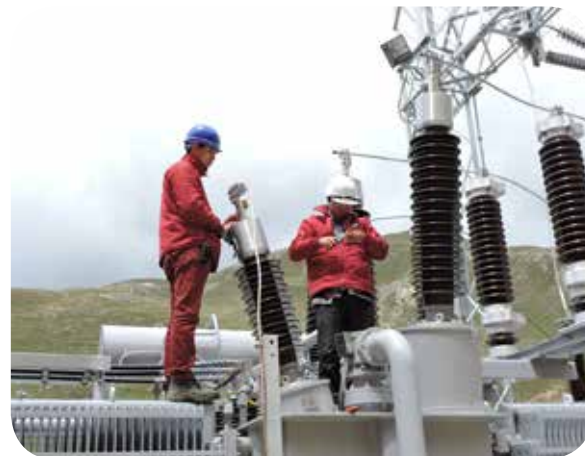
Patio trasero de Canchayllo HPP
