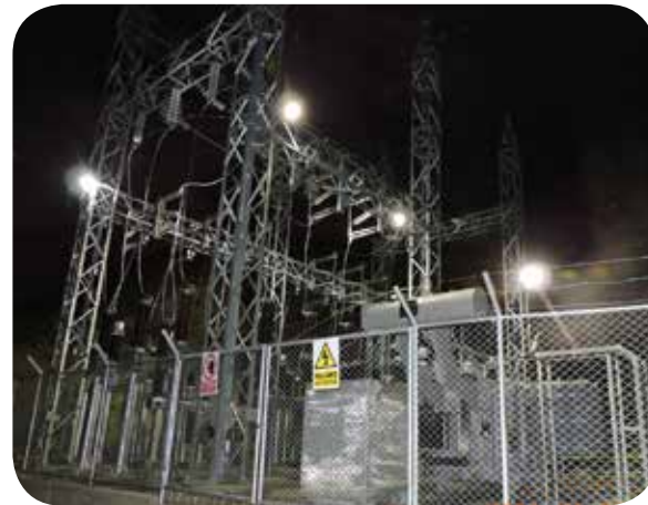
Patio trasero de Canchayllo HPP
