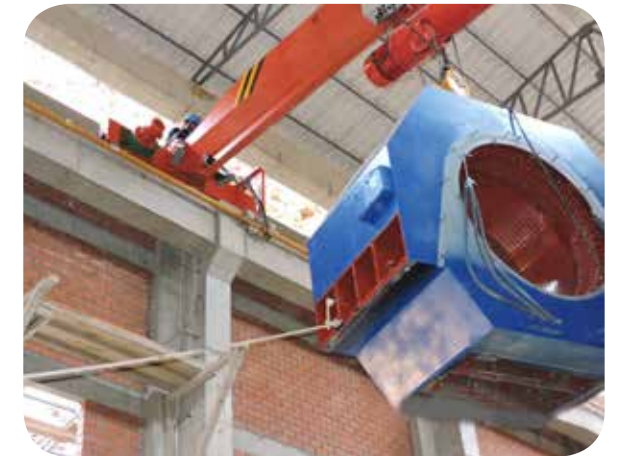
Levantamiento del estator
