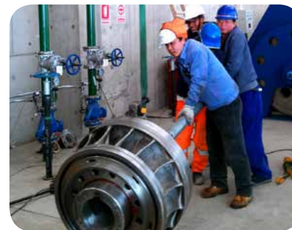
Instalación de corredor
