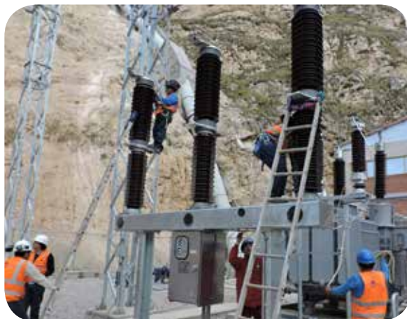
Patio trasero de Canchayllo HPP
