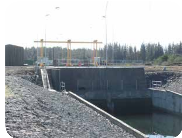
Puerta de admisión delante de la tubería de acero
